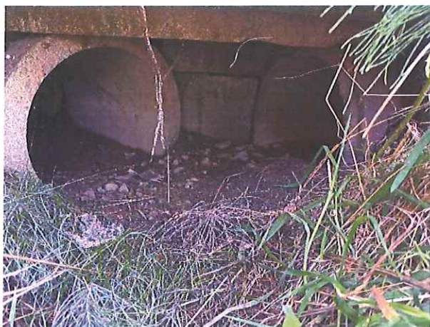
Foto 1: Istniejący wylot przepustów drogowych z urządzeń odwodnienia pasa drogowego ulicy Letniej
